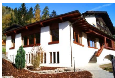
Zubau mit Flachdach und Dachbegrünung
