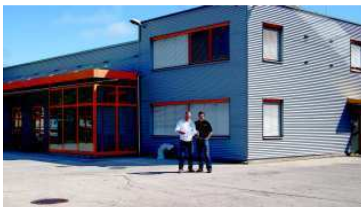
Werner Mayer von PBR-Bau und Stefan Masopust-Sintschnig von motodrom Harley-Davidson vor der bestehenden Halle.
